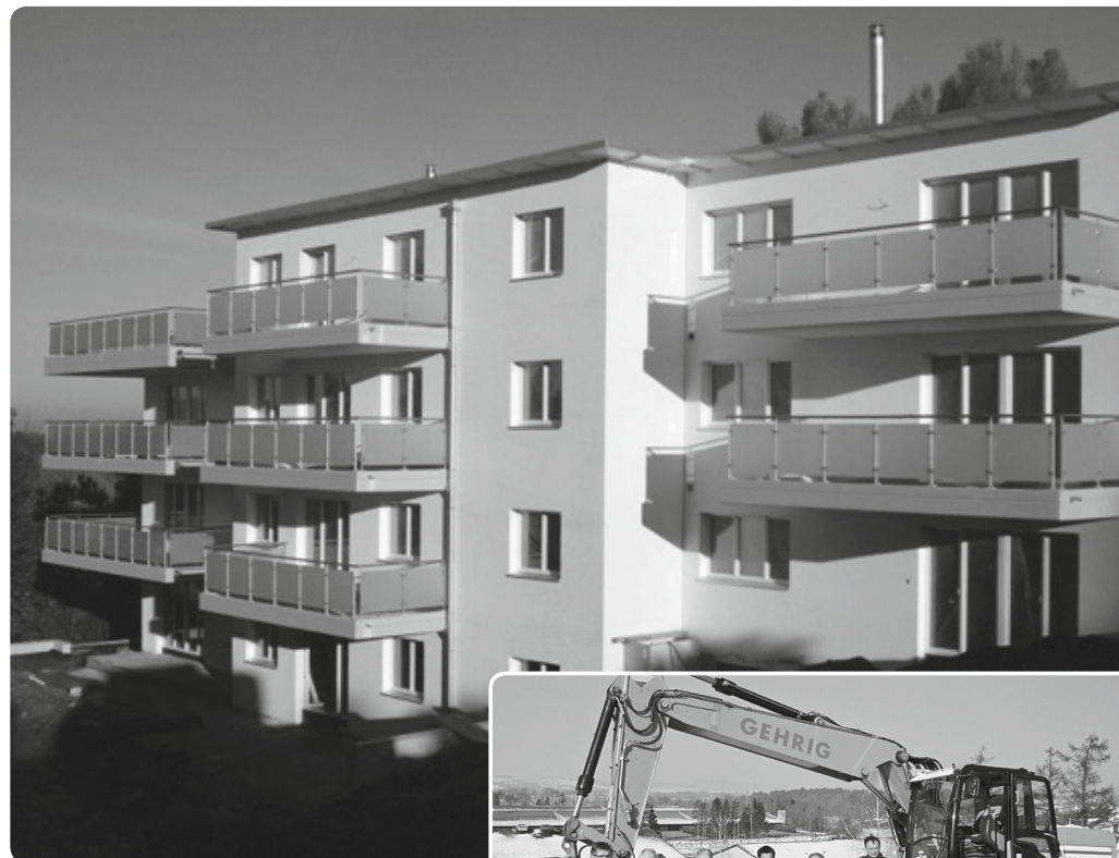
Der Neubau in Bronschhofen: vom Spatenstich bis zum fertigen Objekt.
